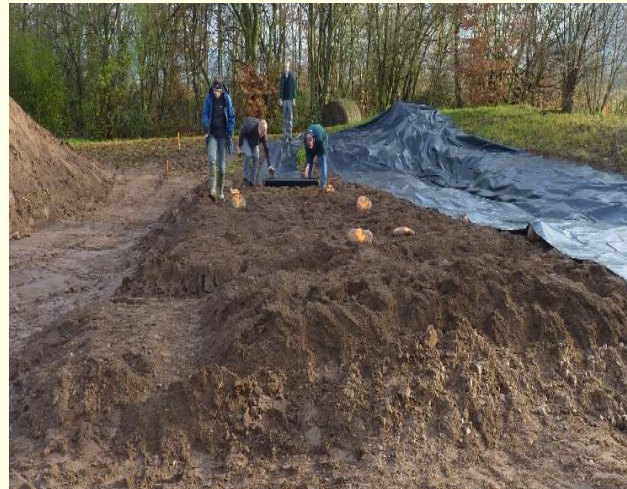
Behandelte Erde wird mit Silofolie abgedeckt!
